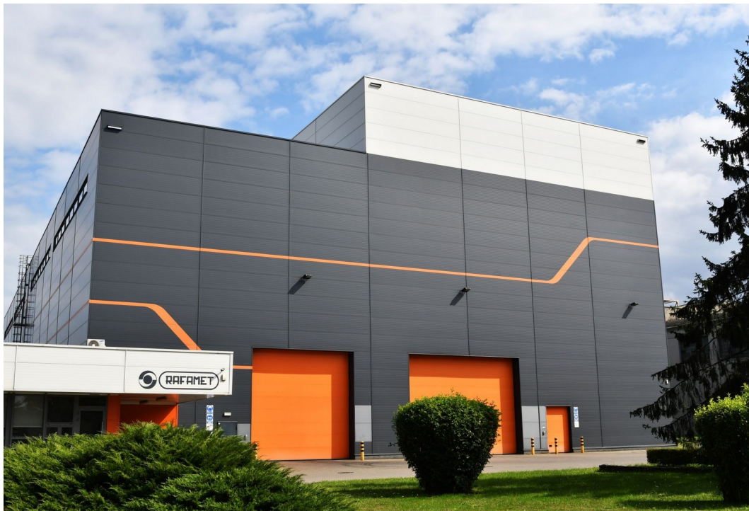
Hala montażu II
